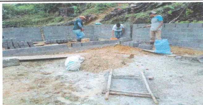
Foto 1: Se inicia la colocación de block en el unico modulo del establecimiento.
