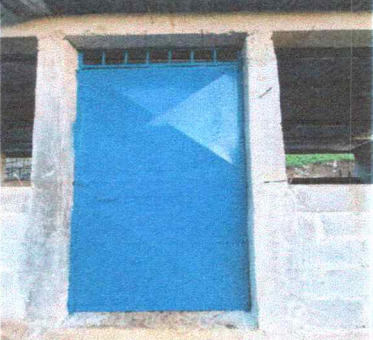
Foto 4: Instalacion de puerta de metal con chapa yale.
