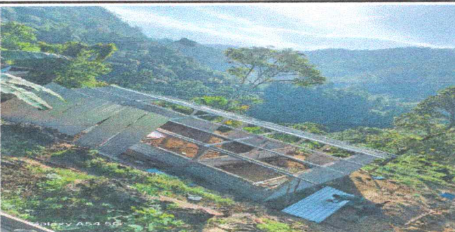
Foto 3: Instalacion de estructura y cubierta de lamina troquelada calibre 26. en el modulo del establecimiento.
